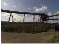
岩手県・陸前高田(9月) ベルトコンベアで山から土砂を運んでいます
